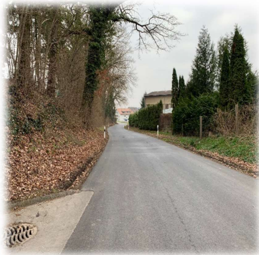
Chemin de Bourlaz
