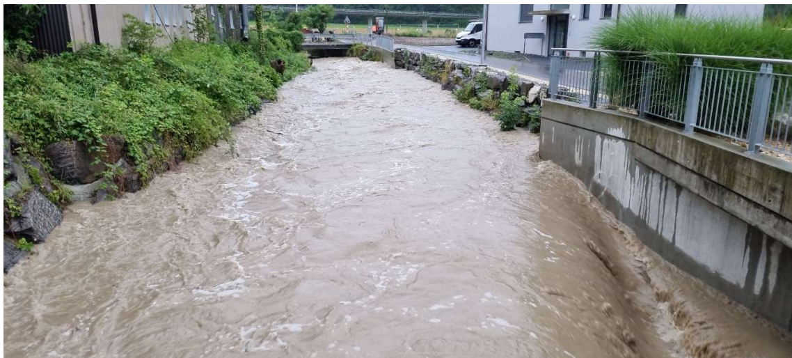
Entrée du canal de dérivation
