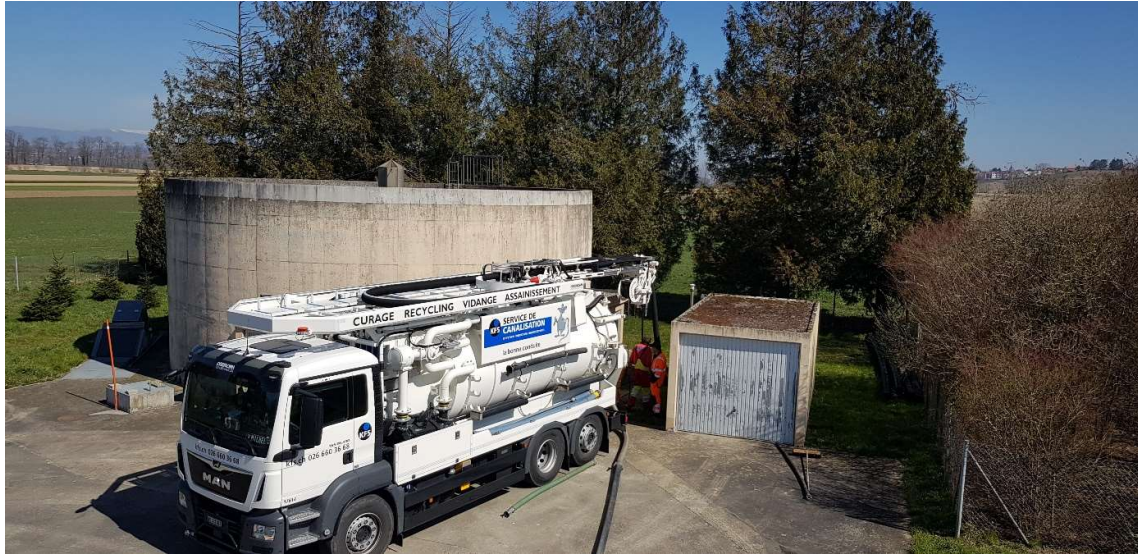
Camion sur site lors des essais de pompage
