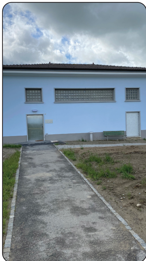
Station de pompage de la Vernaz
