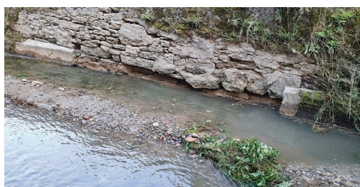
Quelques photos prises pendant les travaux
