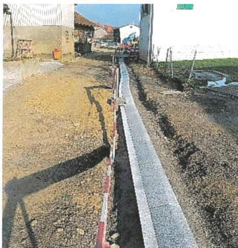
Travaux de mise en séparatif, changement de conduite d'eau potable et aménagement de la super structure Rue Vers-chez-Cherbuin.
